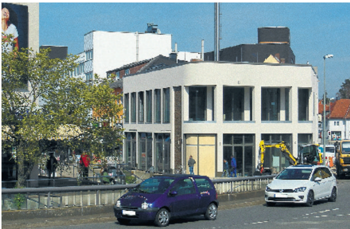
Die letzten Bauarbeiten werden jetzt abgeschlossen. Foto: red
